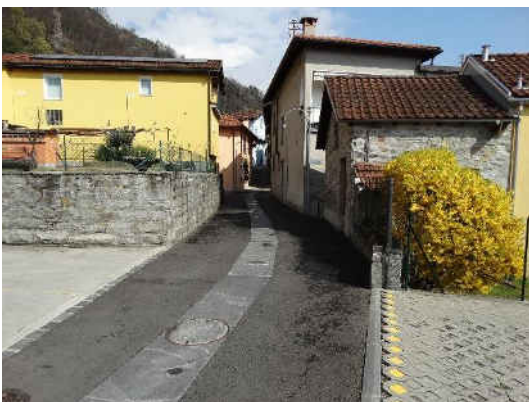
Via alle Vigne - Pavimentazione esistente
