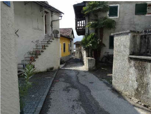
Via al Motto (ovest) – Pavimentazione esistente
