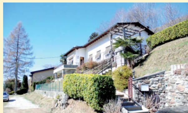
Classificazione energetica PRIMA del risanamento
